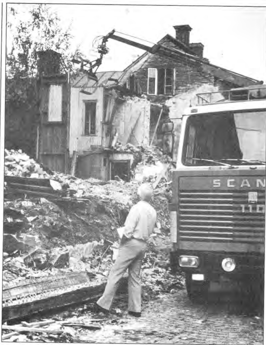
Trapphuset rivs på Öfre Slottsgatan 26 (hösten 1980).
