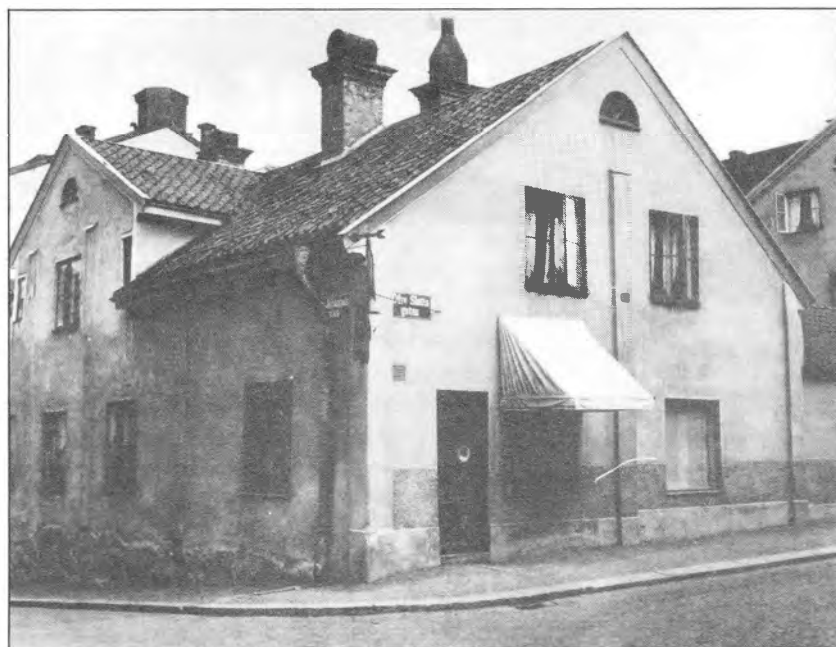
Hörnhuset Öfre Slottsgatan 11 är gatans äldsta hus.
